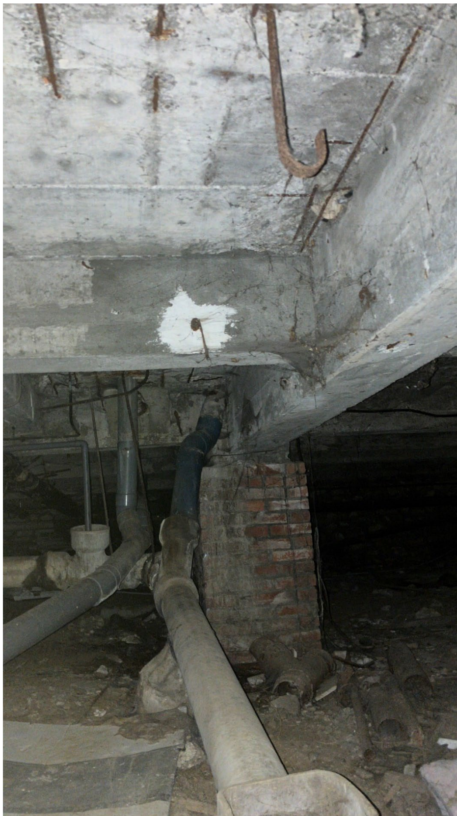
Sondage dallage : SCD103 : Plancher armé avec ferrailage mal enrobé
